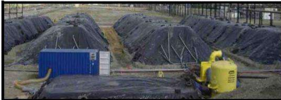
איור 15: ערימות טיפול Bio-Pile באתר טיפול של חברת HPC
