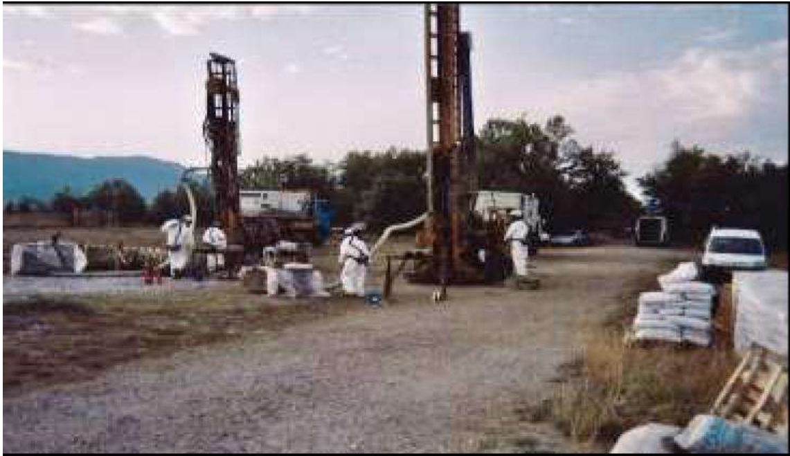
איור 49: חברת HPC שיקום קרקע בשיטת TMT15-Stabilization
