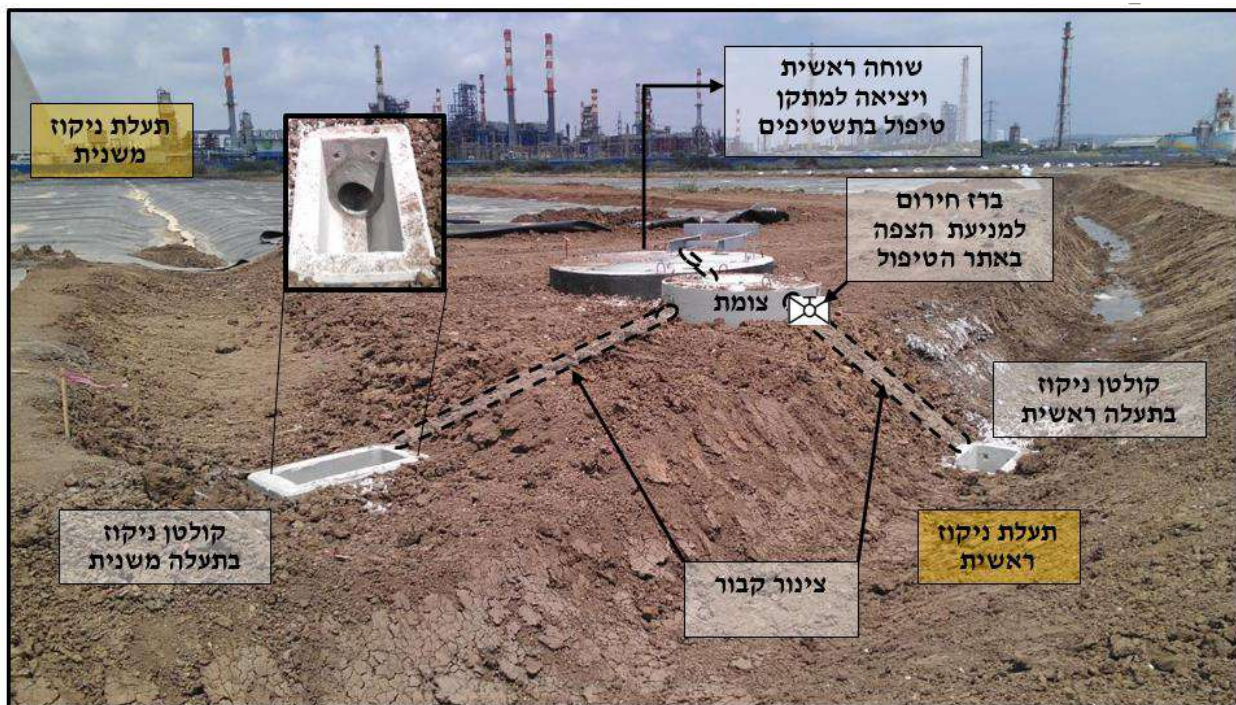
איור 5: מערכות ניקוז על גבי יריעות HDPE (בהקמה) שהותקנו בפרויקט שיקום קרקעית נחל הקישון
