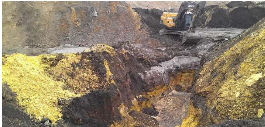
איור 51: תהליך טיפול In-situ שבוצע בבריכת ב"ש 2 בשטח חברה לשירותי איכות הסביבה (אקולוג, פברואר 2014).
