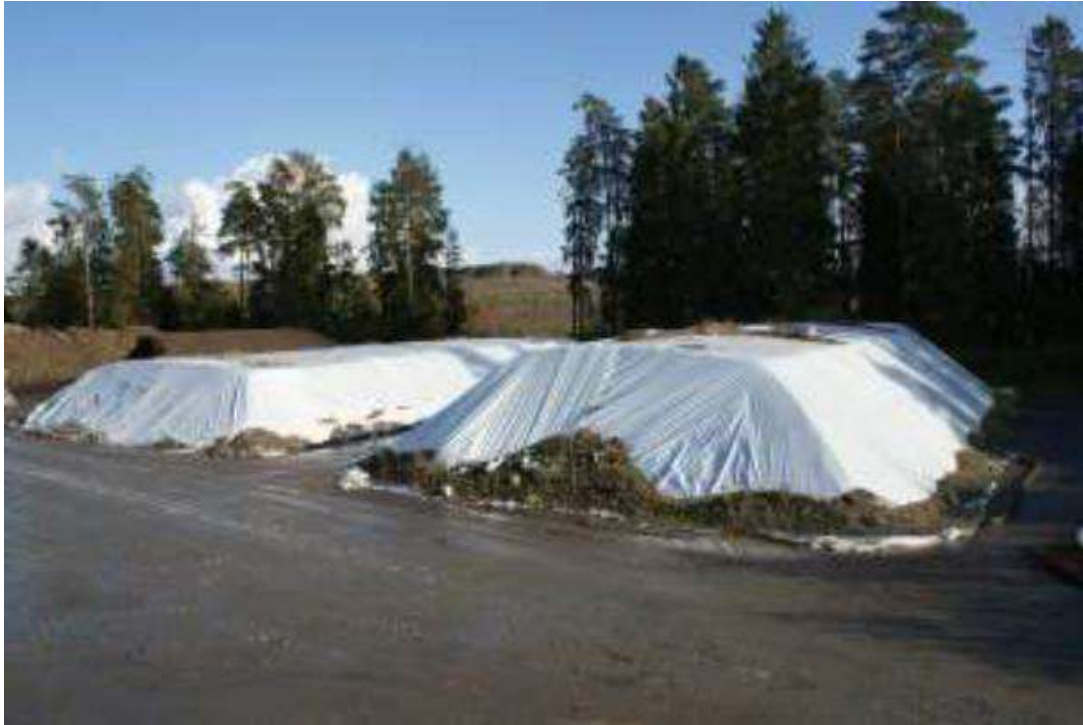
איור 13 : ערימות טיפול Bio-Piles באתר טיפול של חברת RGS90
