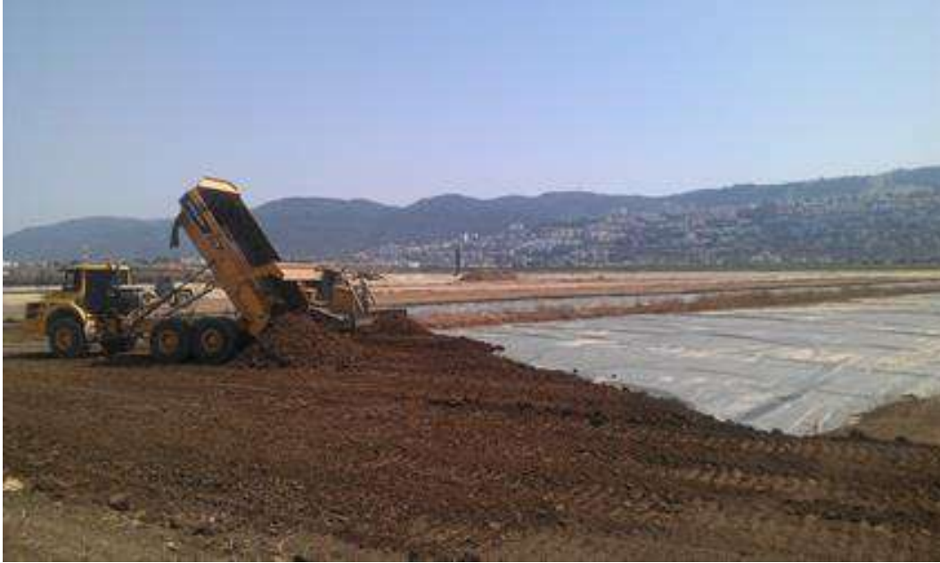
איור 4: הקמת משטחי טיפול ביולוגי על גבי יריעות HDPE אטומות בפרויקט שיקום קרקעית נחל הקישון
